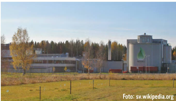
Biogasanläggning i Skellefteå, som rötar matavfall samt tillvaratar den rågas som bildas i det intilliggande reningsverket.
